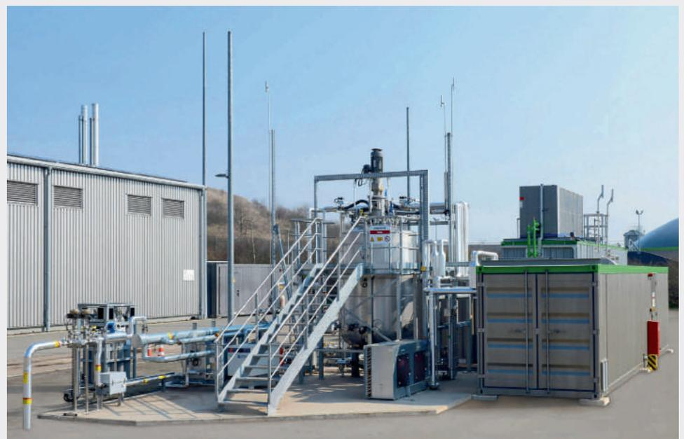
Fig. 6 Biologische Methanisierung Viessmann Anlage Allendorf (Eder)
